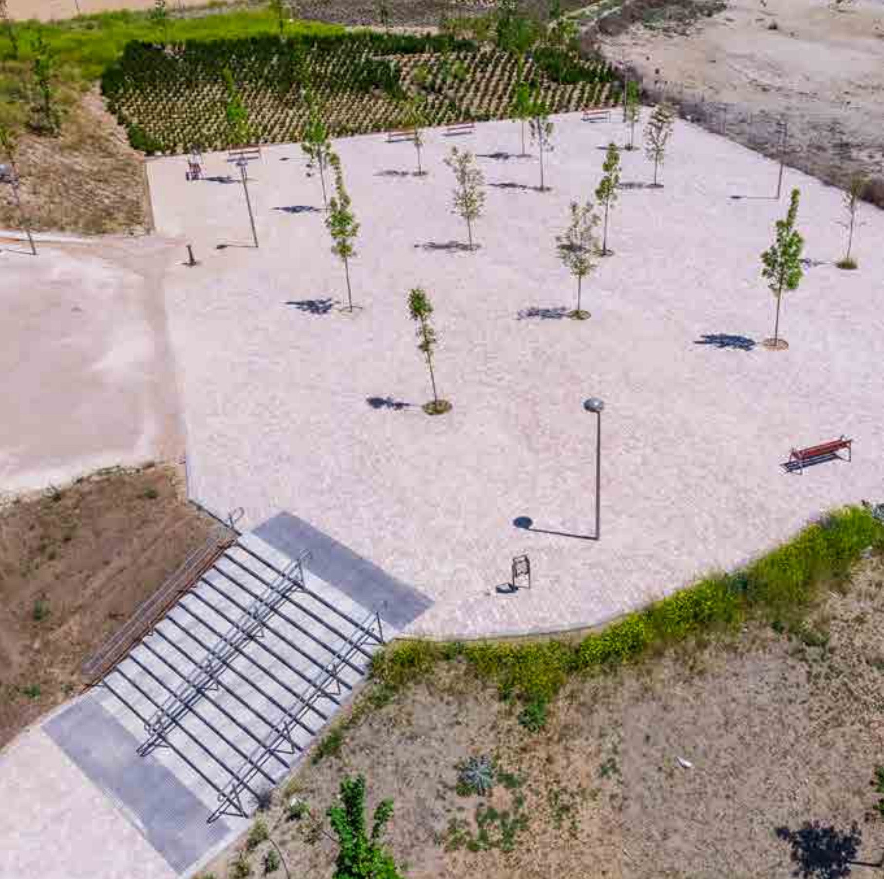
Detalle final de solado drenante con adoquines permeables por junta ECOAQUA , con acabado envejecido WEEKEND consistema FITBLOCK , en el parque de la Gavia de Madrid
