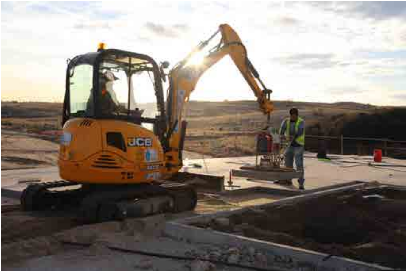
Detalle de colocación de losas de gran formato mediante pluma y ventosa.
