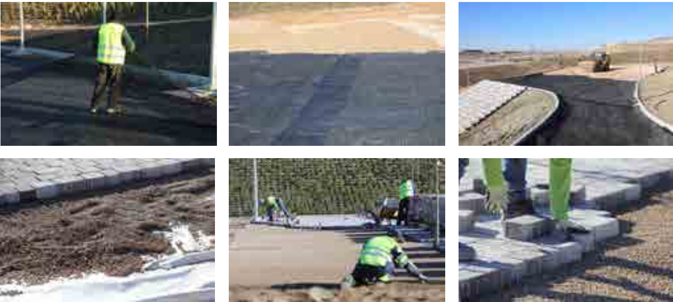
Detalle de desarrollo de realización de sección drenante ECOAQUA : Extensión de la geomalla-realización de la capa de zorra drenante. Colocación de geotextil-subbase de capa de gravilla. Colocación de los adoquines permeables por junta ECOAQUA con sistema FITBLOCK y relleno de juntas.
