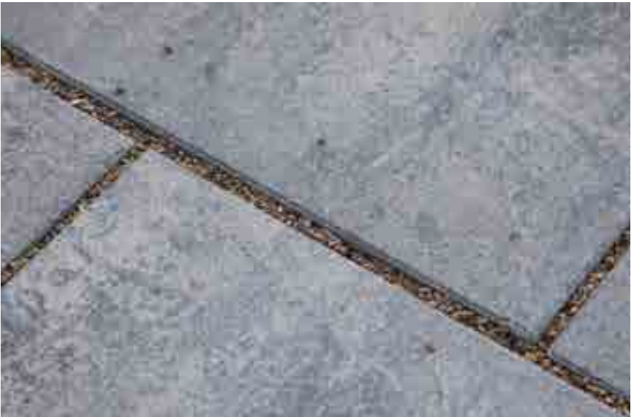
Detalle de relleno de grava en las juntas drenantes a través del sistema FITBLOCK
